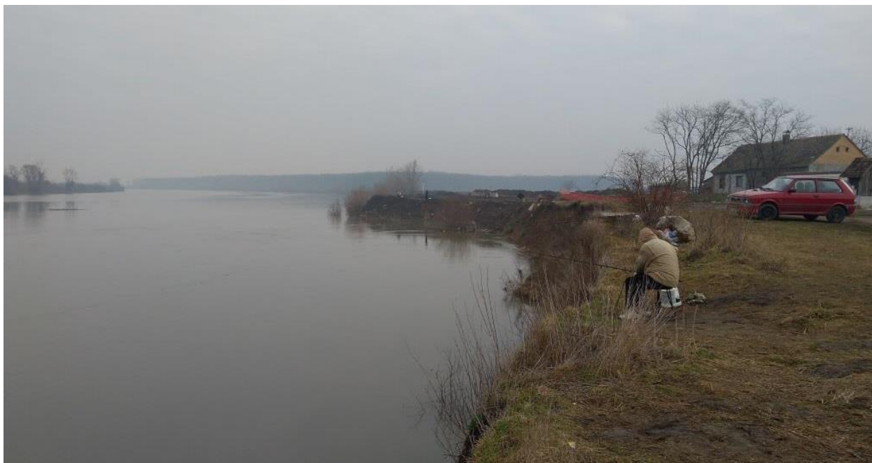
Slika 04. Najznačajnija oštećenja obale na projektnoj deonici
